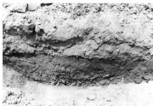
第58図 2001-10地点第2トレンチ断面写真
