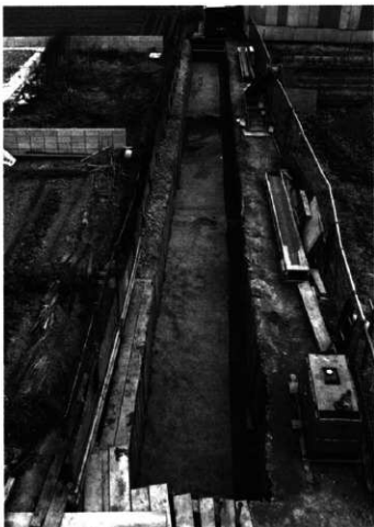
長原1層基底面遺構(西から)
