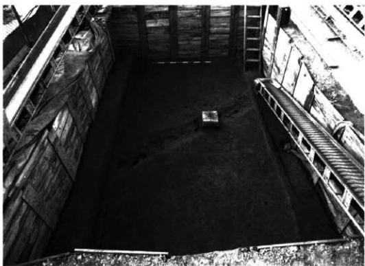
2区SD701(北西から)
