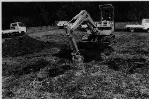
・平坦部調査風景
