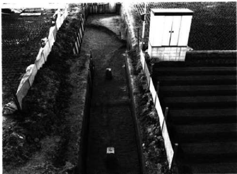
Ⅱ区 SR10・20～22 (東から)
