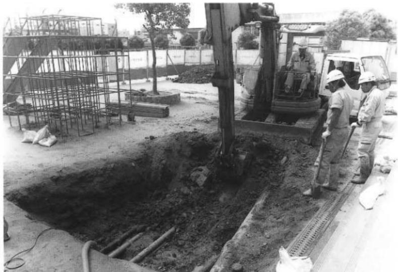
重機による表土掘削風景（北西から）
