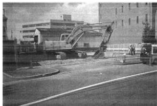
調査地全景(東から)
