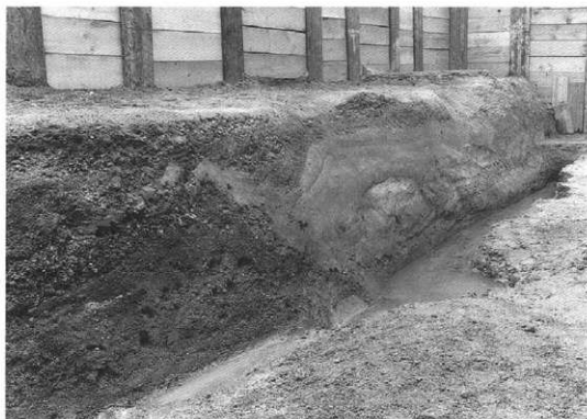
南壁地層断面(北東から)
