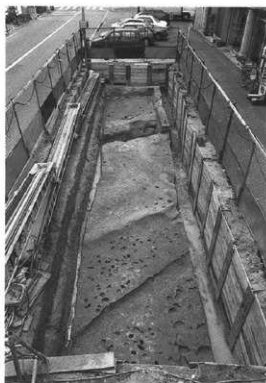
長原6B1層上部上面検出遺構(東から)
