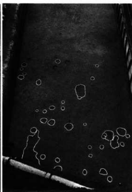
Ⅲ区 SB04 周辺 (北から)
