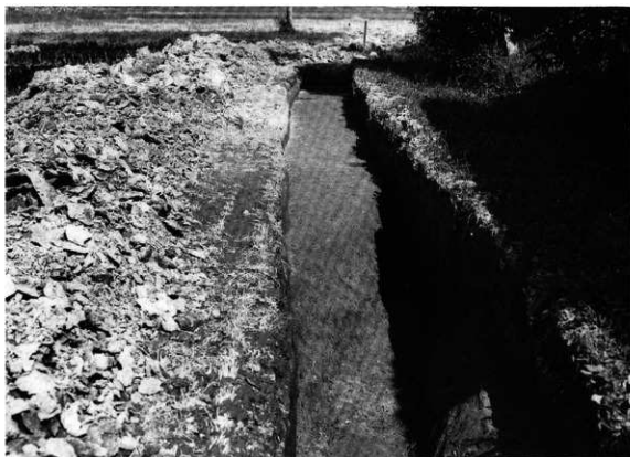
第16トレンチ全景
