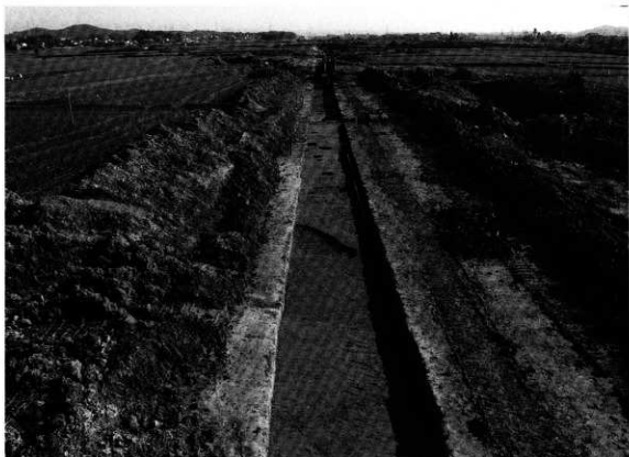
第27トレンチ全景
