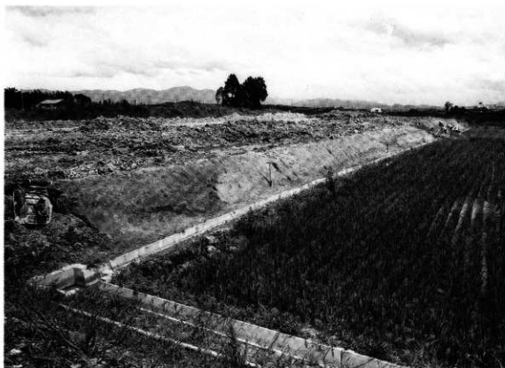
29号道路区調査前(西から)
