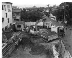
ショベルカーによる表土剥ぎ
