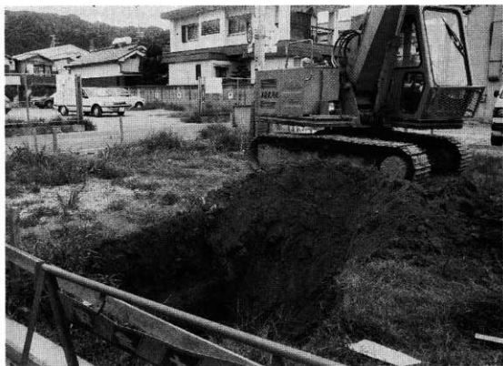
掘削状況 (北西から)
