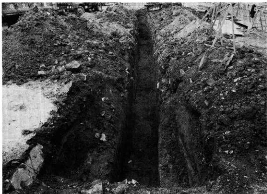
掘削状況 (南から)
