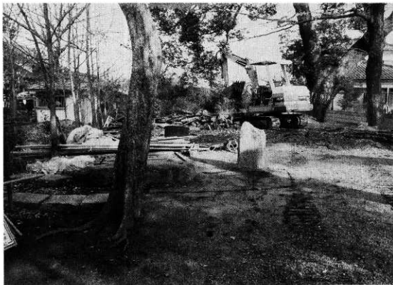
東トレンチ掘削前（南から）
