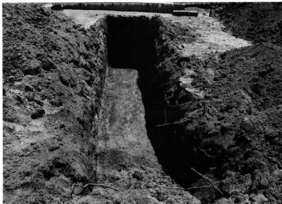
拝殿トレンチ掘削状況（西から）
