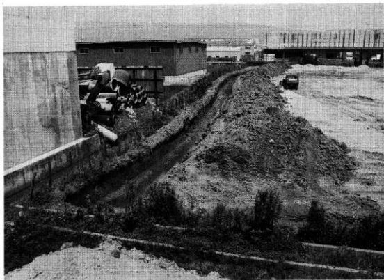
第1トレンチ全景（西から）
