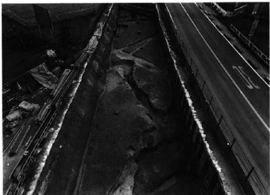
調査地全景（北西から）
