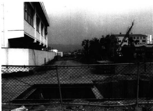
西区近景（西から）
