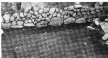
写真19 排水溝側石上の石積み
