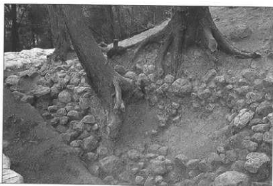
T9トレンチ 基底石・葺石崩落状況
