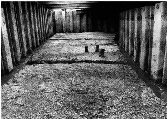
K-1A地区全景 (南から)
