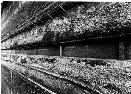
第5調査区 第1調査面全景 (西から)
