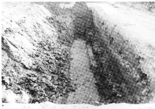
浄化槽調査区全景
