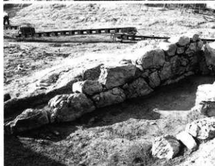
左 右側壁 (南東から) 右 左側壁 (南西から)
