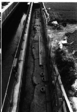
西区 全景(東から)
