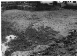
写真3 一ヶ塚古墳の保護砂による埋戻し
