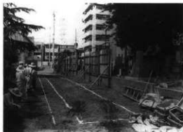
写真4 93-22次調査前の状況(南から)
