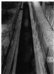
写真14 93-31次調査地全景(南から)
