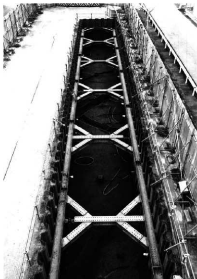
第8層の遺構 (東から)
