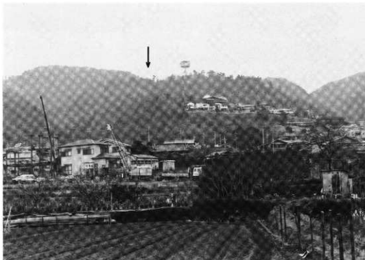
(1) 古墳遠景 (南から)
