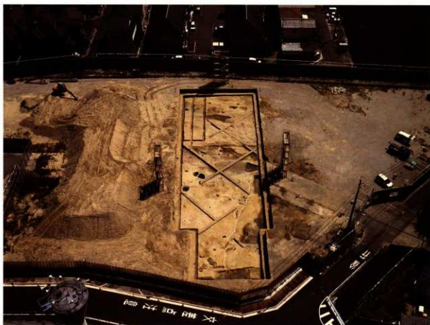
a. 07-1区全景斜め写真（北西から）
