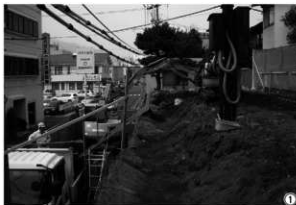
1 段目掘削状況
