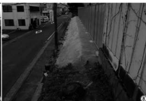
盛土完成状況
