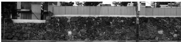
石垣解体修理後（合成写真・南から）
