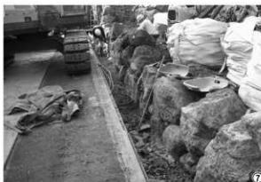
側溝解体状況
