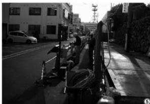
仮囲いの設置
