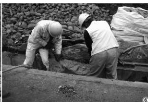
側溝解体状況
