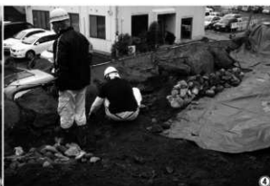
築石撤去状況
