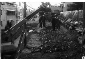
天端裏込め状況
