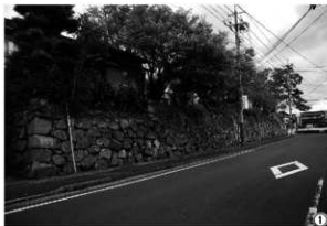
石垣解体前全景（南西より）
