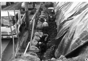
9段目掘削状況
