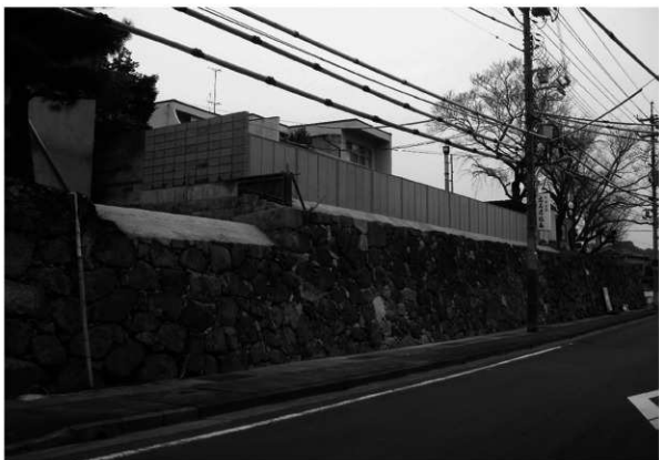
石垣解体修理後（南西から）
