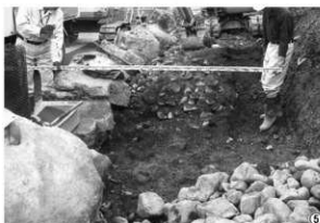
石垣天端より 2.35 m下の状況
