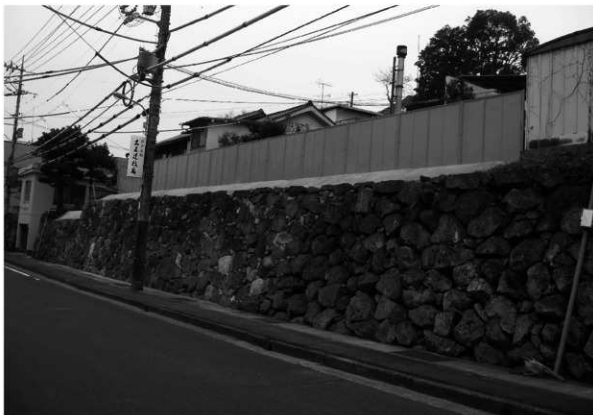
石垣解体修理後（南東から）
