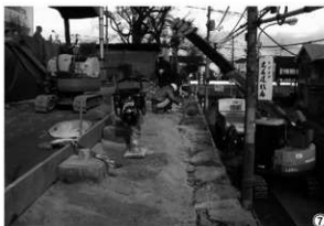
三和土盛土状況
