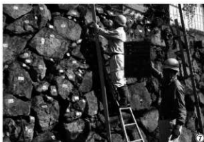
仮丁張り状況
