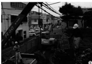
1 段目石垣撤去状況
