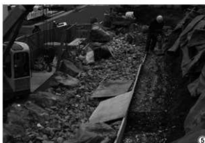
改良土埋の戻し状況
