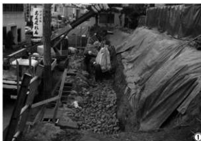
裏込め栗石状況 (6 段目)
