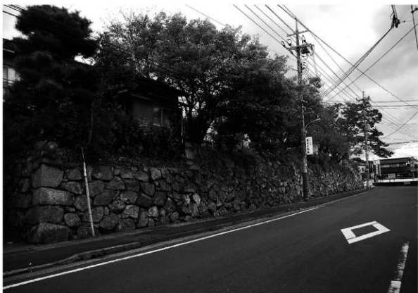
石垣解体修理前（南西から）
