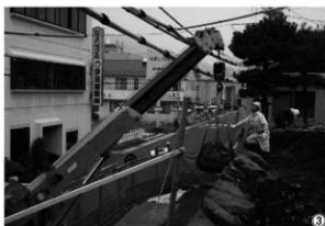
1 段目築石運搬状況
