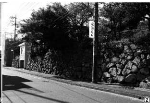
石垣解体前全景（南東より）
