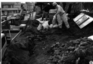
築石運搬状況
