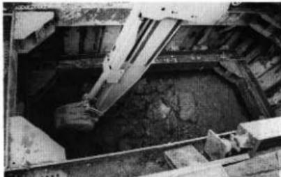
機械振削（3次振削）
