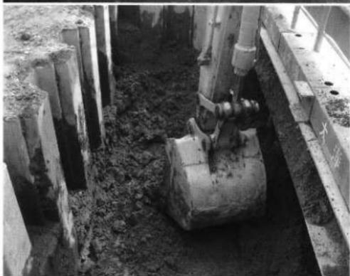
機械掘削 [T.P. +3.25mまで] （西から）
