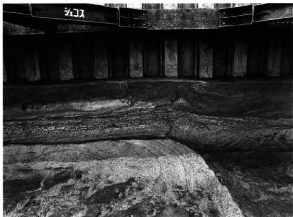
西壁に残る地震の痕跡(噴砂、挽み、東から)
