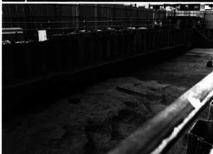
西壁断面 (第3-2層まで、 南東から)
