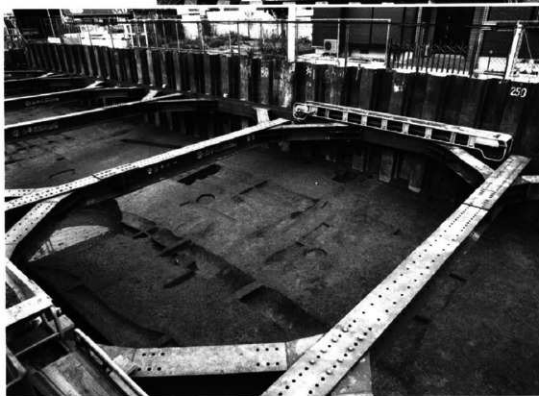
北部遺構掘削状況（南西から）
