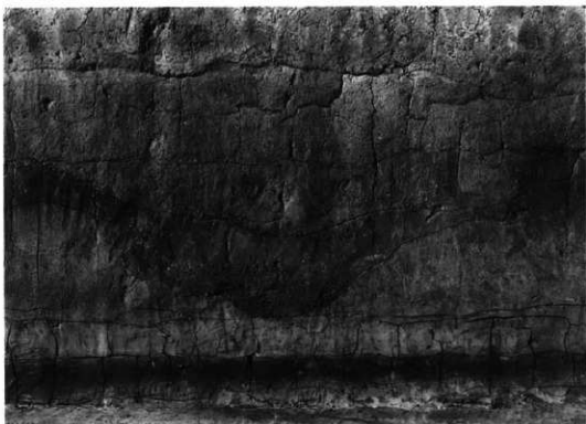
IV区SD610北壁断面
