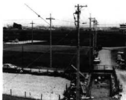
写真2 87-16次(Ⅰ区)調査作業風景
