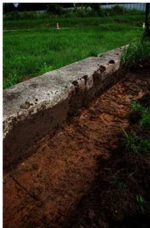
Tr321 古代道路側溝 (南西6-5)
