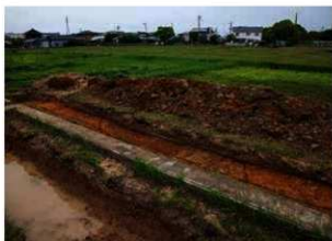
Tr333 北辺 古代道路側溝検出 (南から)
