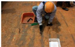
遺構掘削作業状況
