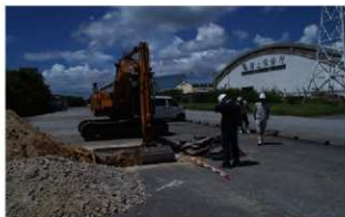
試掘調査状況
