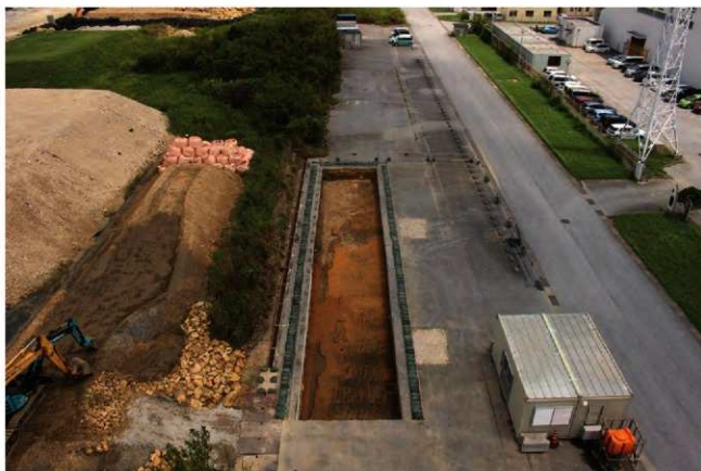
巻頭図版 1 上：調査区全景(東から) 調査区後方に見えるのは那覇空港管制塔、さらに奥には第2滑走路 下：調査区全景(南から)
