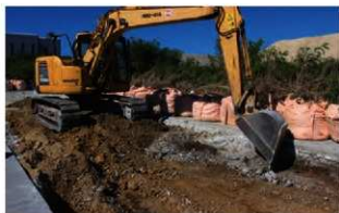
調査区機械掘削状況
