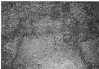
清掃後の状況
