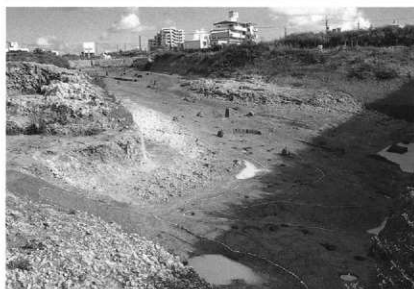
雨天後の水溜遺構と溝状遺構
