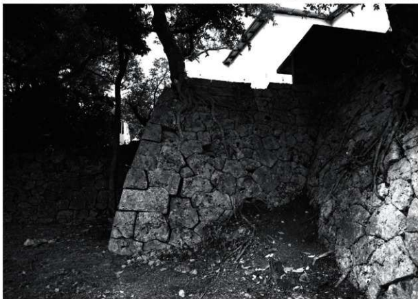
図版2 石積B・C面の状況 上段：石積B面の状況（西から） 下段：石積C面の状況（南から）
