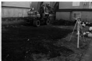
A 事業地近景(北から)
