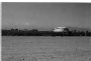
D 調査状況(北東から)
