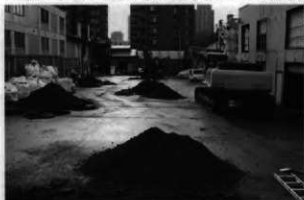
A 事業地近景(北から)
