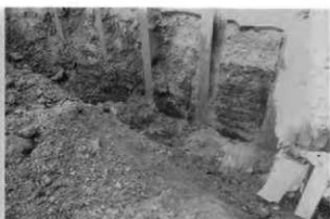
F 工事立会状況
