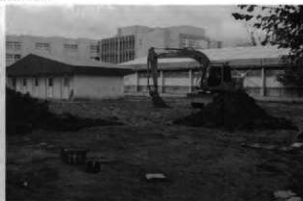
B 事業地近景(北東から)
