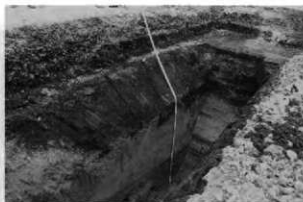
G 工事立会状況
