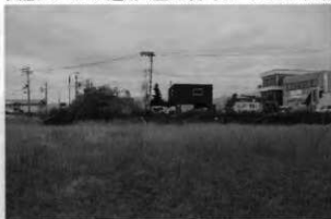
A 事業地近景(北東から)
