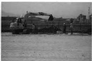
E 調査状況(北東から)
