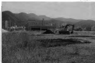
A 事業地近景(北東から)
