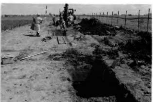
H 調査状況(北西から)
