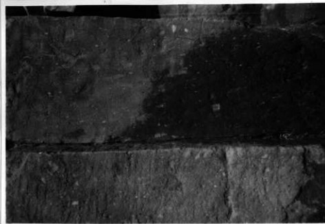
31 鋼板の溶接部を拡大して撮影した様子
