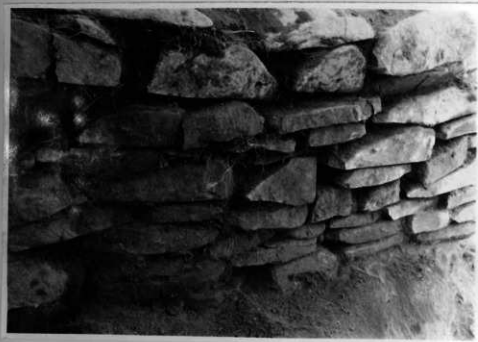
30 玄室壁石積み細部の状態
