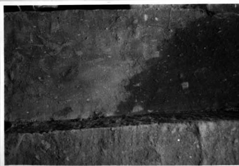
32 鋼板の溶接部を拡大して撮影した様子
