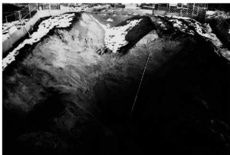
(3) 3トレンチ東横(西から)
