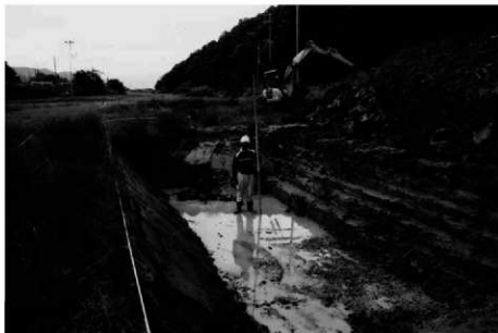
(1) 1トレンチ 重機掘削状況 (南から)
