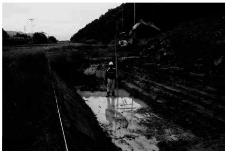
(1) 1トレンチ 重機掘削状況 (南から)
