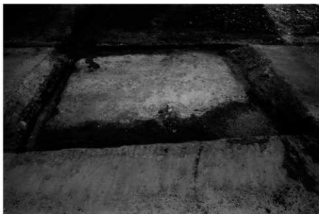
(3) 3トレンチ 市道北拡張区完掘 状況(西から)
