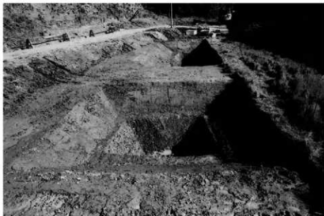
(1) 2トレンチ 完掘状況(北から)
