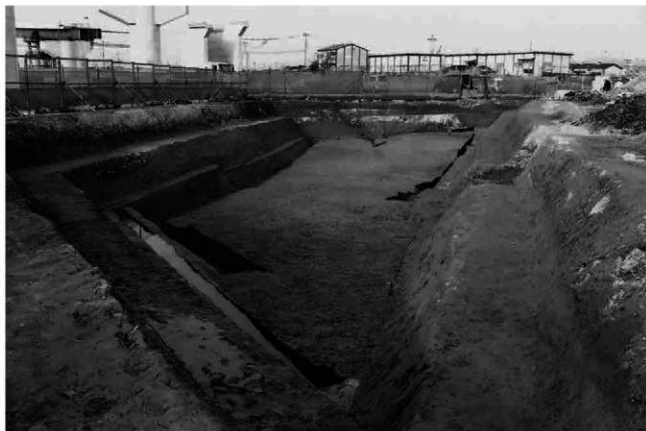
(2) B4区下層遺構全景(南西から)
