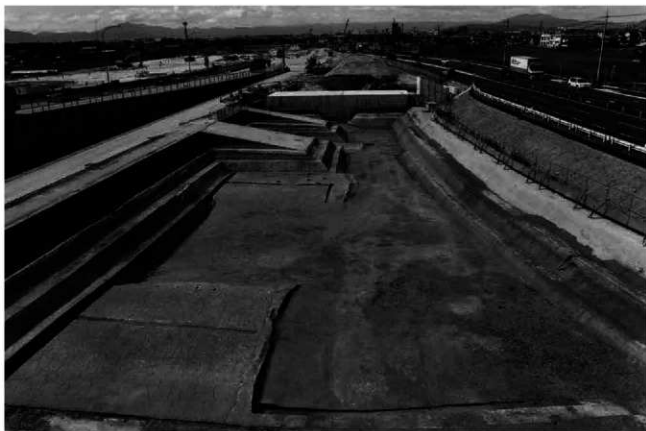
(2) H地区北半部全景(南から)
