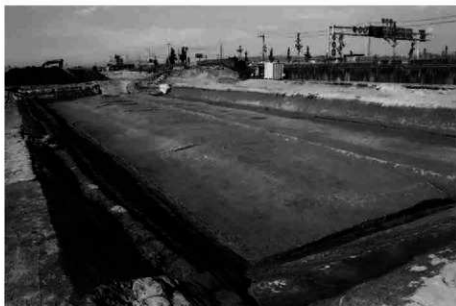
(1) J地区(南半部)鳥畑59全景 (南東から)
