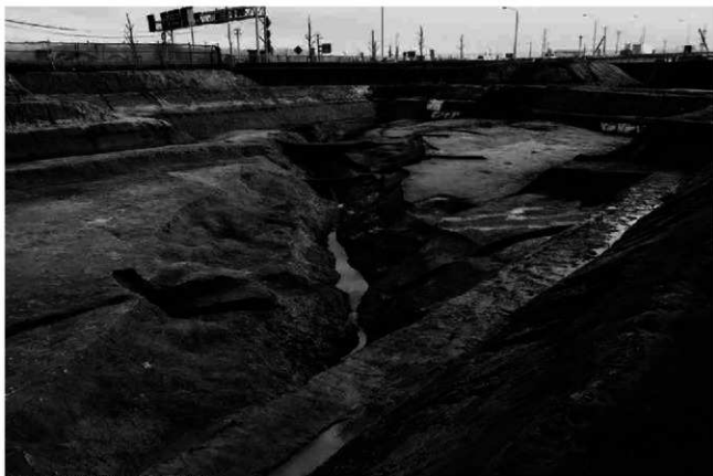
(1) J 地区溝 S D04 全景(北西から)
