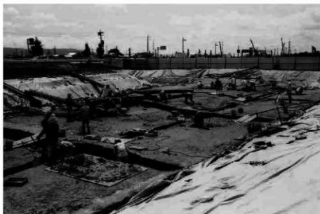
(1) L地区下層断ち割り作業風景 (北西から)
