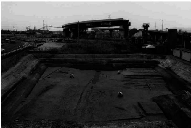
(1) H地区南半部全景(北から)
