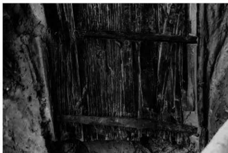
(3) H地区溝SD25方形組み合わせ 木製品部分拡大(南東から)
