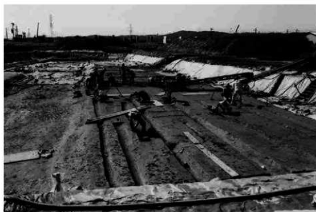
(3) N 地区作業風景(北から)
