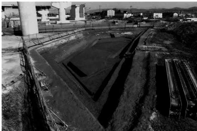
(1) B4区上層遺構全景(南西から)
