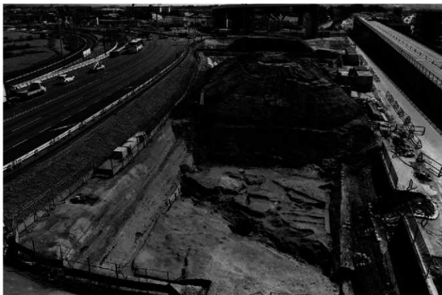
(2) H地区溝 S D 25 全景(北から)
