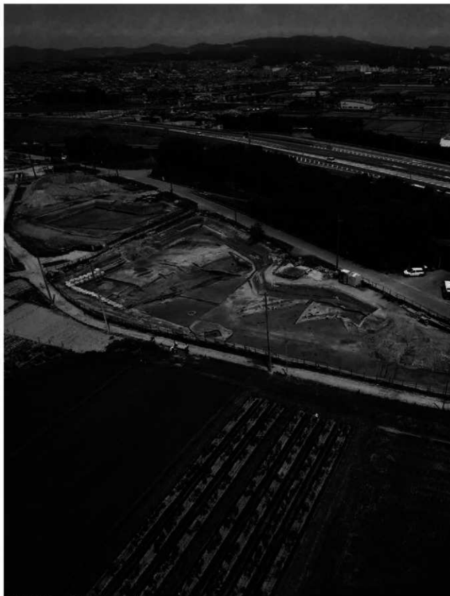
調査地全景(A～C地区、南西から)
