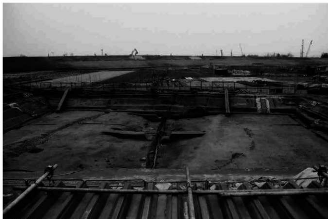
(1) B地区下層遺構面全景(東から)
