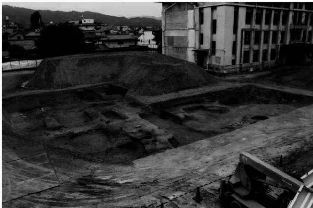
(1)北地区北西部(6トレンチ)全景(北西から)
