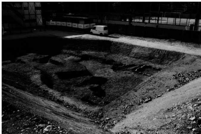
(1)北地区北西部(6トレンチ)全景(南東から)
