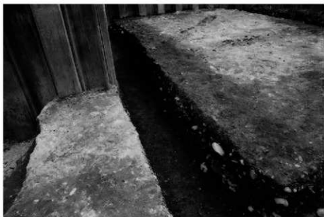
(2) 南地区北部(9トレンチ)断面 (北西から)
