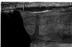
6. 1区19号住居地割れ (噴砂) : bの断面②
