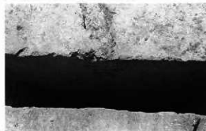
7. 1区19号住居亀裂断面（北より）
