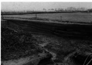
4 同1 北側の立ち上がり
