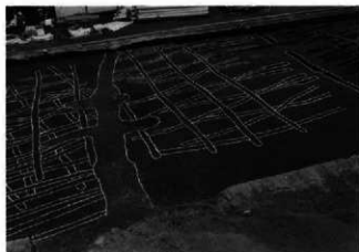
3 同1 確認状況(北から)
