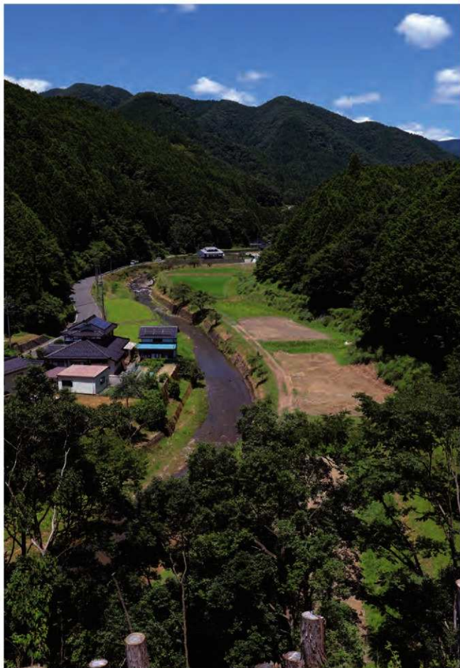
調査地遠景(上が北)
