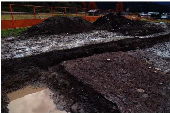
(2) 6 トレンチ土層(西から)
