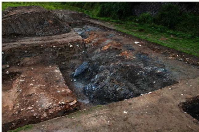
(1) 3 トレンチ 岩盤検出状況(南から)
