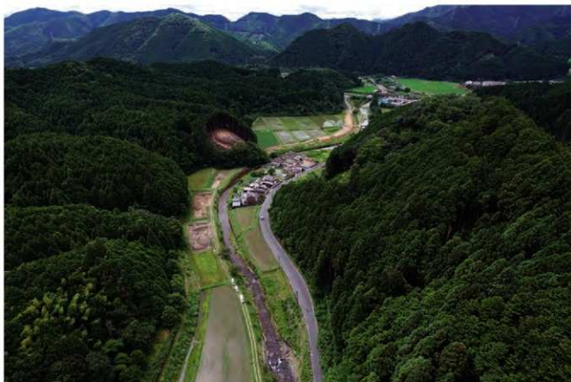
(1) 調査地遠景(北から)
