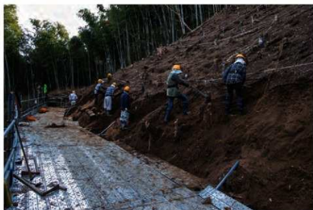
(3) 斜面掘削作業状況(北から)
