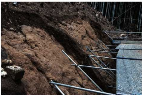
(2) 1区・2区北畔断面土層 (南から)
