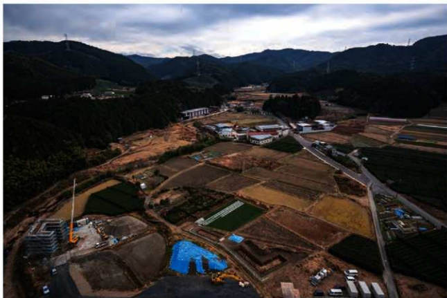
(1) 調査地遠景(北西から、大打川上流を望む)
