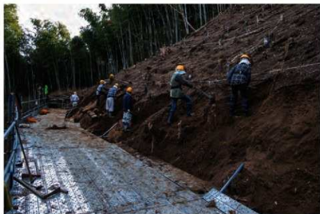
(3) 斜面掘削作業状況(北から)
