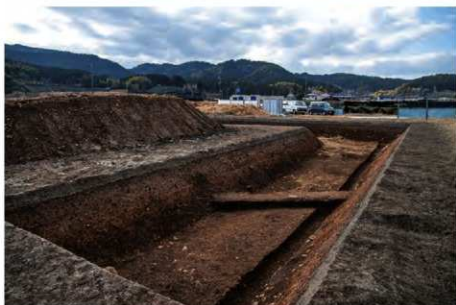
(2) 2区東西部完掘状況(北東から)
