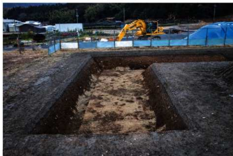
(1) 2区南北部完掘状況(南から)
