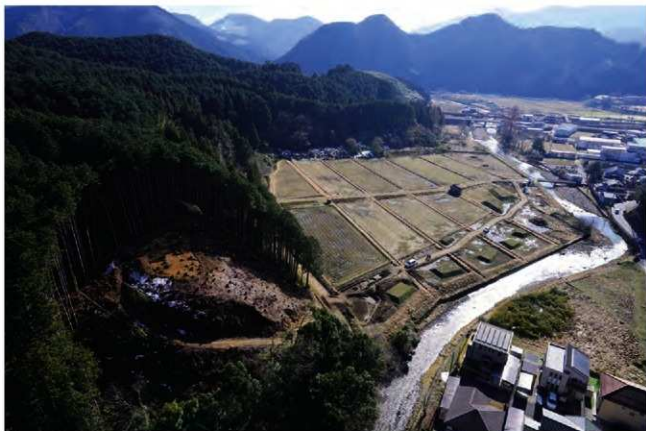
(1) 調査地遠景(北西から)
