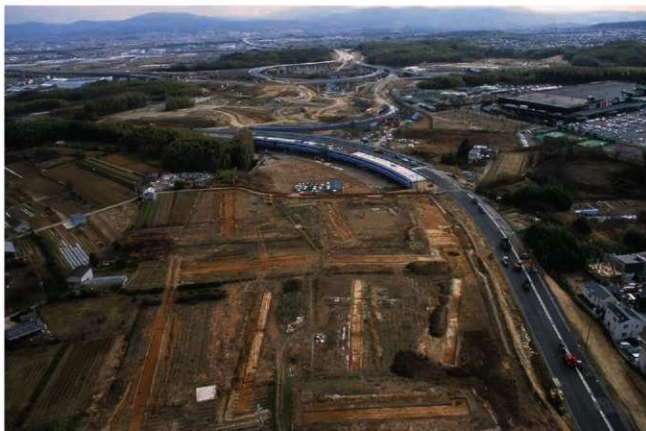
(1) 第6次調査区トレンチ全景(東から)
