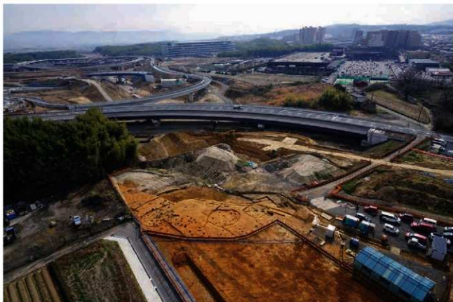
(1) 第9次東調査区全景空撮(西から)
