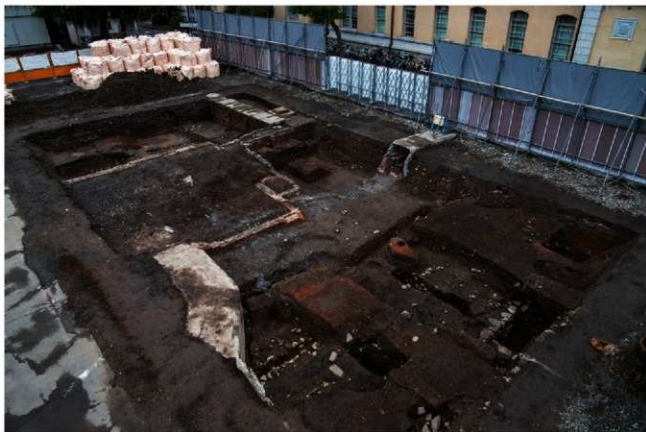
(2)第1面1区北側全景(北東から)
