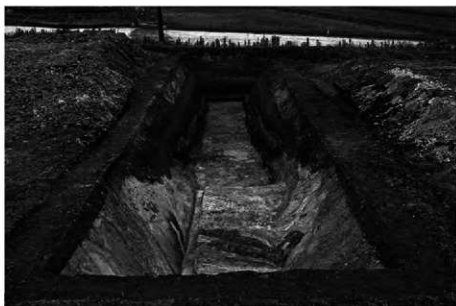
(2)19区完掘状況(南東から)
