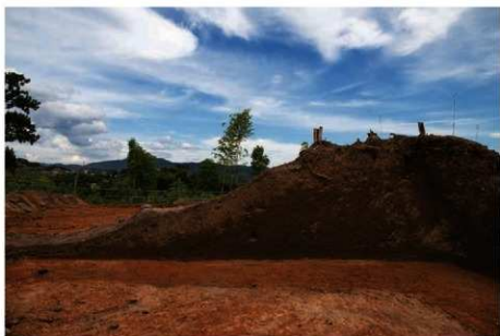
(3) 盛土南側断面(東から)
