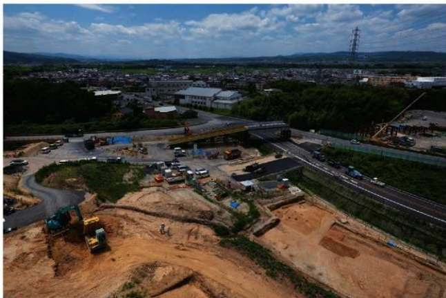
(1) R-3地区遠景(北から)
