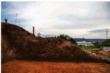
(2) 盛土北側断面(東から)
