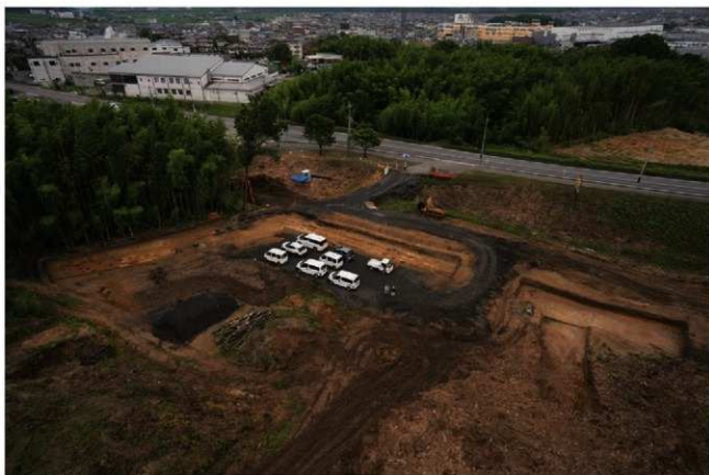
(2) Q地区遠景(北東から)
