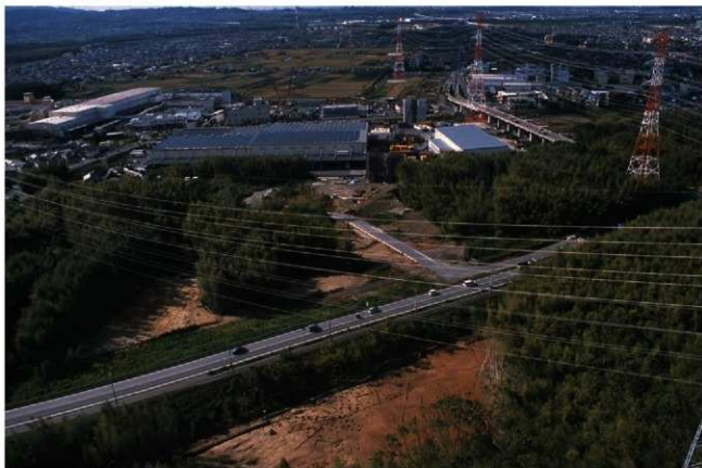
(1) M-1地区遠景(南東から)
