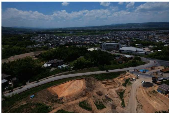
(2) V-1地区遠景(北東から)
