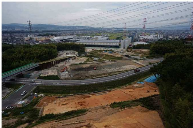
(1) R-4地区全景(東から)
