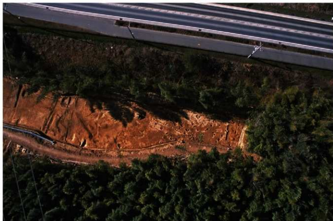
(1) I地区北半近景(上が西)
