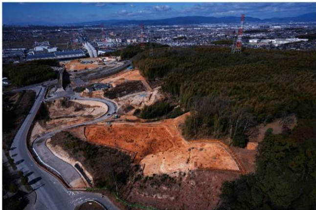
(1) V-5地区遠景(東から)
