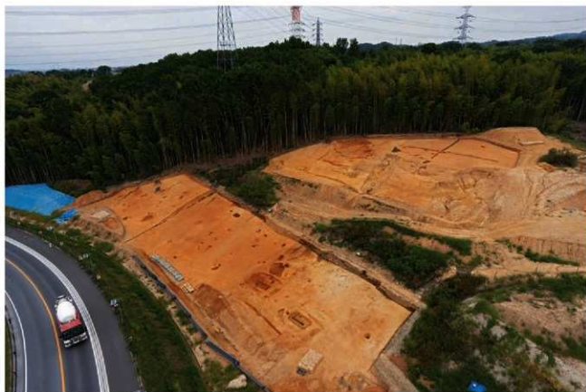
(2) R-4地区全景(北西から)
