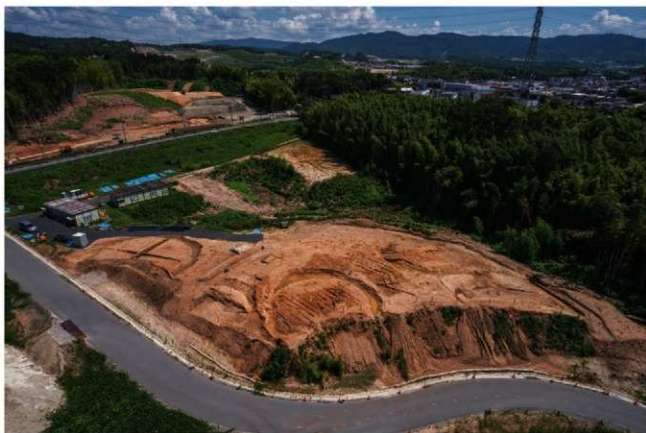
(2) O地区全景(西から)
