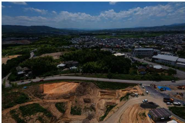
(1) V-1地区遠景(北から)
