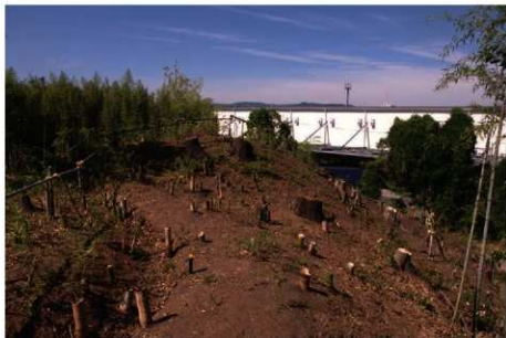
(1) H-1地区調査着手前状況 (北東から)
