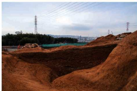
(2) 谷状地形 NR04断面c-c' (北東から)
