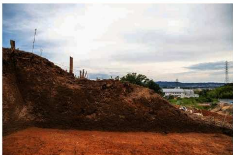
(2) 盛土北側断面(東から)
