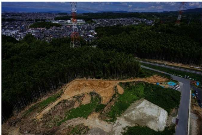
(1) P地区西側全景(南西から)
