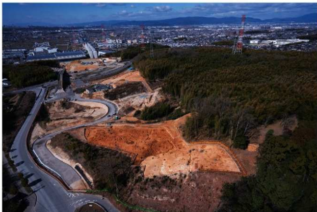
(1) V-5地区遠景(東から)
