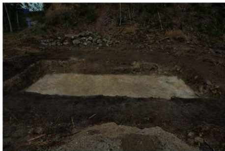
(3) C地区8トレンチ全景(南から)
