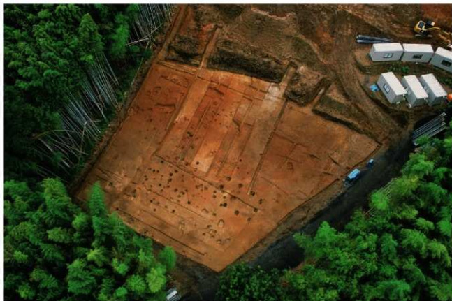
(1) A地区全景(南西から)
