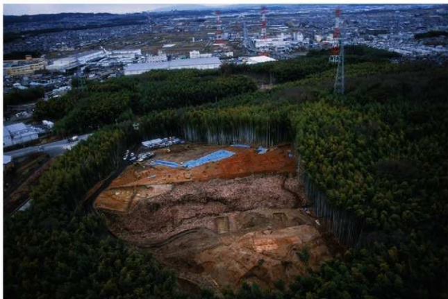
(1)E地区調査地遠景(東から)
