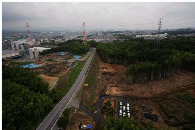
(1)Q地区遠景(南東から)
