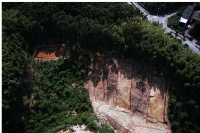
(2) K地区全景(西から)
