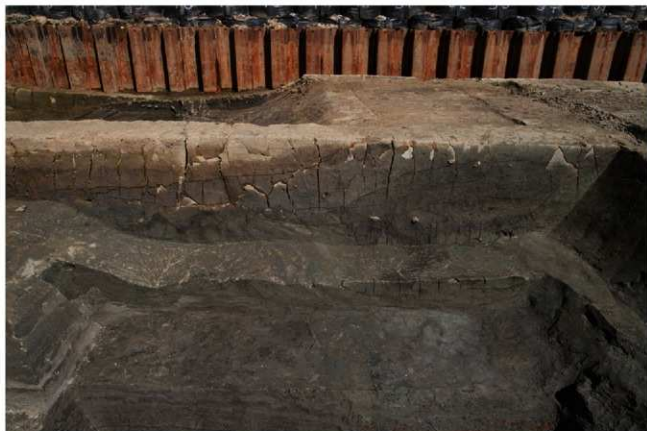
(1) 溝SD102断面(南から)
