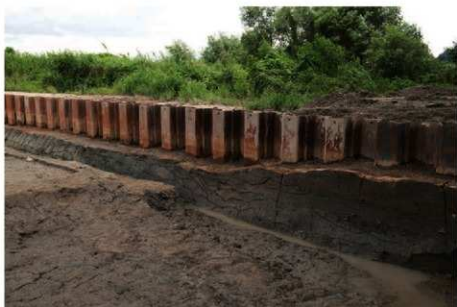
(1)南壁断面①(西から)
