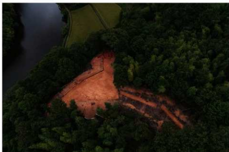
(2) II区掘削状況(北から)
