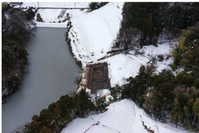
(2)調査地遠景(北から)
