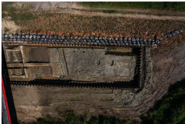
(2) 遺構面東側掘削状況(上が北)
