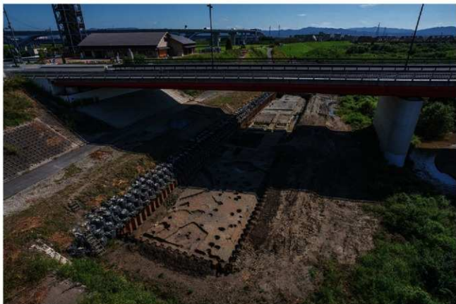
(1) 遺構面掘削状況(西から)
