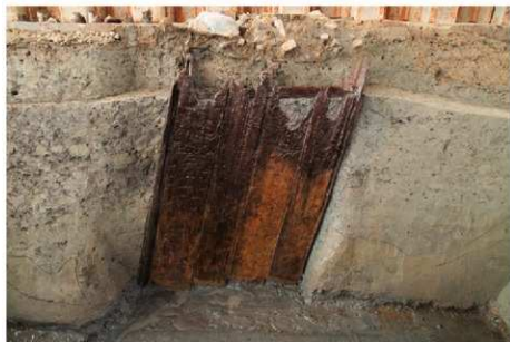
(1) 井戸SE65南縦板2列目 検出状況(南から)
