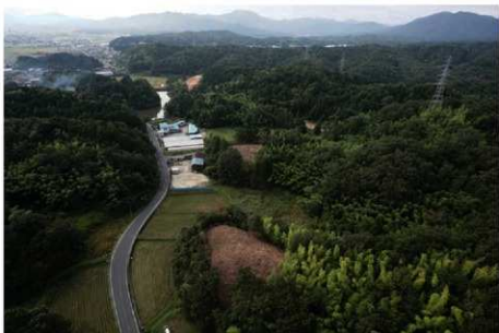
(1)調査地遠景(北から)
