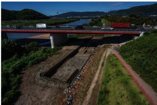
(2) 遺構面掘削状況(東から)
