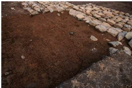
(1)北辺階段裏込め土出土状況 (南東から)
